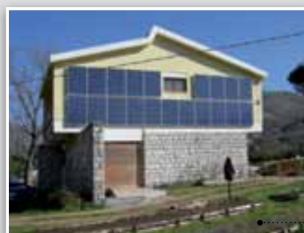
Sistemi in facciata. Foto Reverberi Enetec
